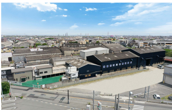
本社・第一工場
