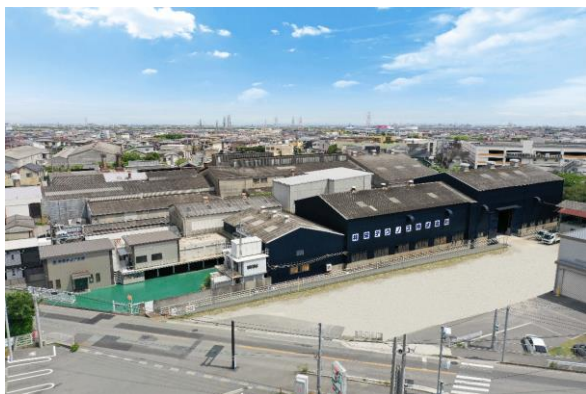
本社・第一工場
